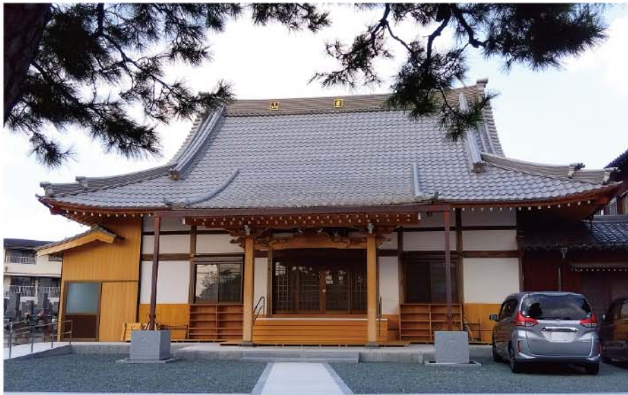
↑明治34年以來の大改修がなされ、令和5年に完成。 左手のスロープからは車椅子でも本堂に入れる優しい作り。
